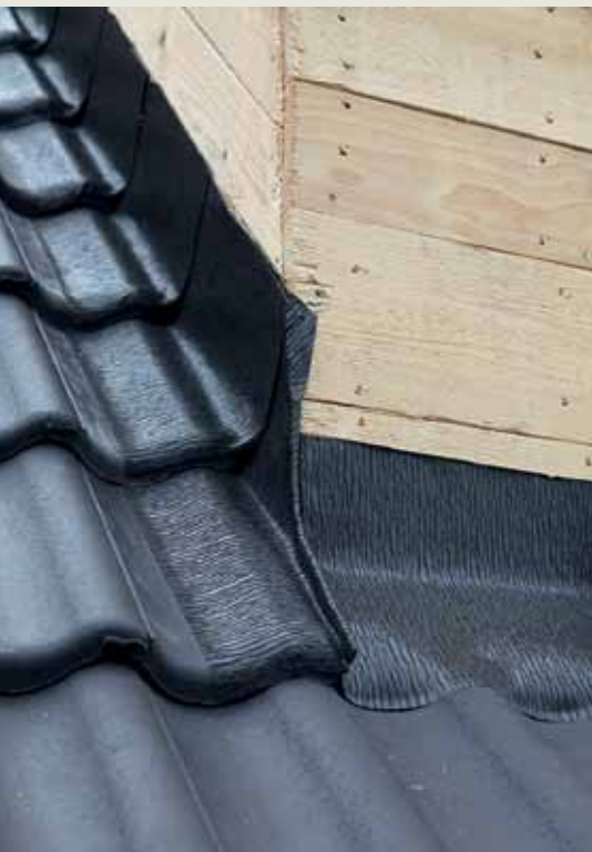
Die Gaubenanschlüsse wurden mit einem rollbaren Anschlussband mit Verstärkungsgitter und unterseitiger, vollflächiger Butylbeschichtung in Schichtstücken sowie Stehfalz ausgeführt.
