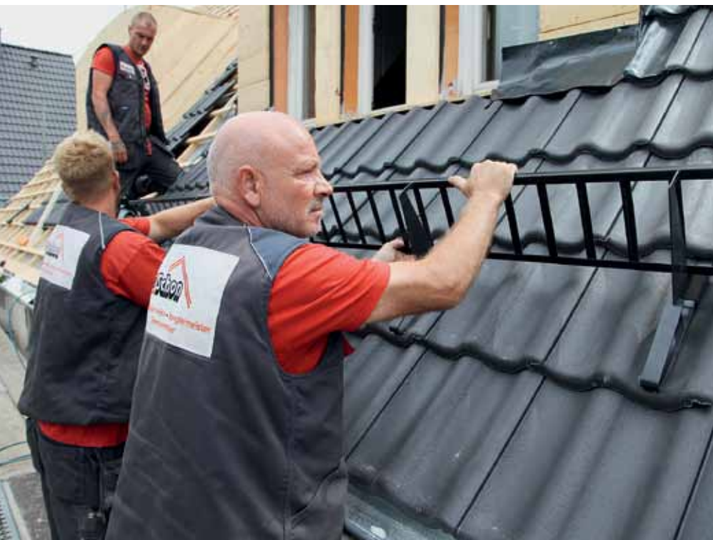
Die Verkehrssicherungspflicht (BGB), diverse LBO's und die DIN EN 1991-1-3 schreiben es vor: Schneeschutzsysteme zur Abwehr von weißen Dachlawinen.
