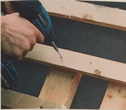
▲ Die Lattung wird ausgespart und der Bereich durch zwei Konterlattenstücke unterstützt
