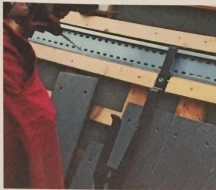
▲ Die Befestigungsschiene wird dann über zwei Sparren befestigt und der Haken verschraubt
