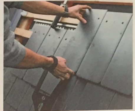
▲ Anschließend kann die Biberschwanzdeckung fachgerecht begedeckt werden
