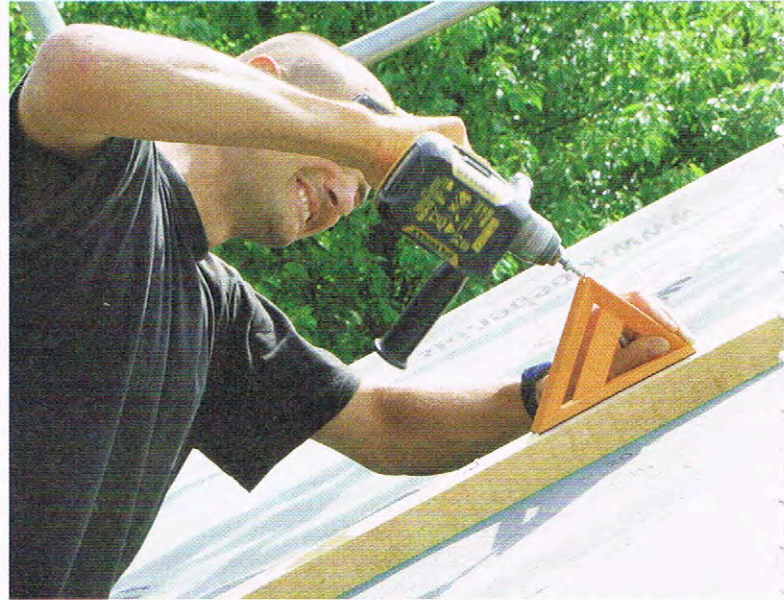
▲ Eine weitere Möglichkeit der Lagesicherung ist die Fixierung mit schubsichernden Systemschrauben im 60-Grad-Winkel
