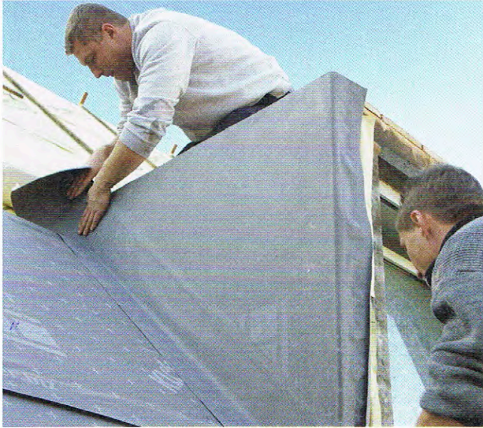
▲ Mit den abgestimmten Elementen eines Dämmsystems ergeben sich gerade in der Dachsanierung wirtschaftliche Lösungen
