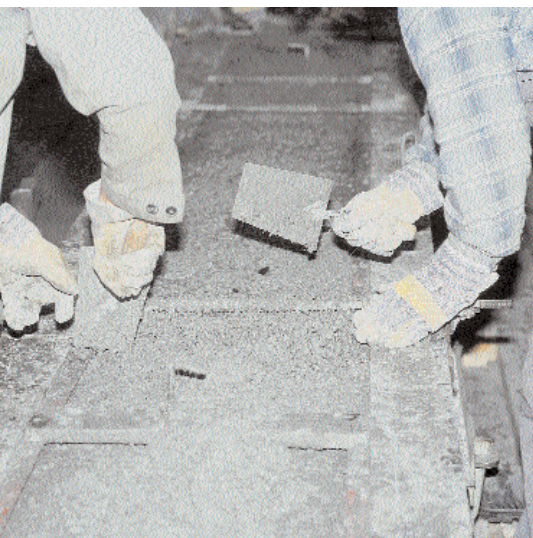
Bild 6: Sorgfältiges Abreiben und Glätten bei der Produktion der Stützen
