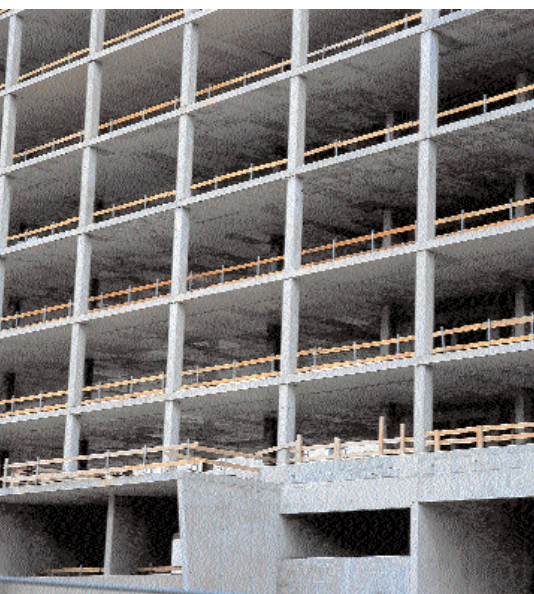
Bild 1: Hochfeste Betonfertigteilstützen beim Neubau eines Verwaltungsgebäudes in Frankfurt-Niederrad
