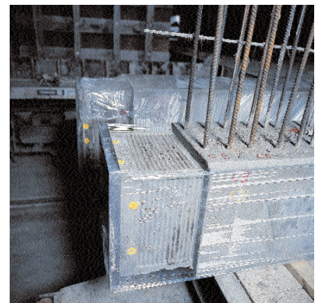
Bild 3: Der DYWIDAG-Kompaktknoten kurz nach dem Entschalen im Werk
