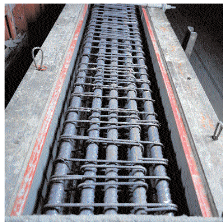
Bild 2: Hochfeste Stähle in den Stützen aus hochfestem Beton eröffnen neue bautechnische Perspektiven.
