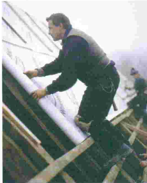
Mittels Konterlattung wird die Unterdeckbahn befestigt
