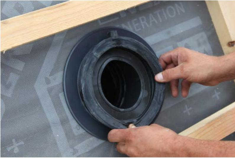
◀ Der Dämmstoffdurchgang wird luftdichtend, regen- und windsicher ausgeführt
