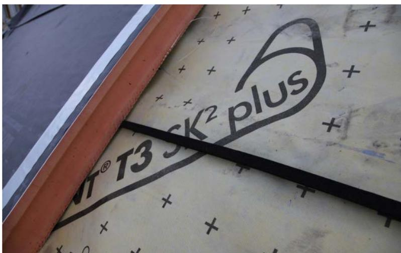
▶ Anschließend konnten die Handwerker die Dämmelemente auf der Luftsperrse verlegen
