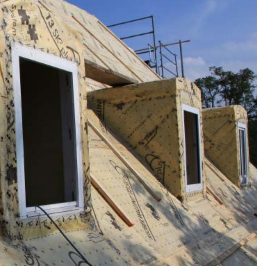
◀ Die Dachfläche in Hanau wurde komplett abgeräumt und mit einer neuen luftdichtenden Dampfsperre mit einem  $s_d$ -Wert von 3 m „eingepackt“
