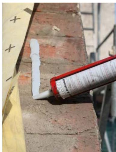
◀ Die Anschlüsse der neuen Luftsperr Ebene an aufgebende Bauteile erfolgten mit einem systemkonformen Kleb-Dichtstoff
