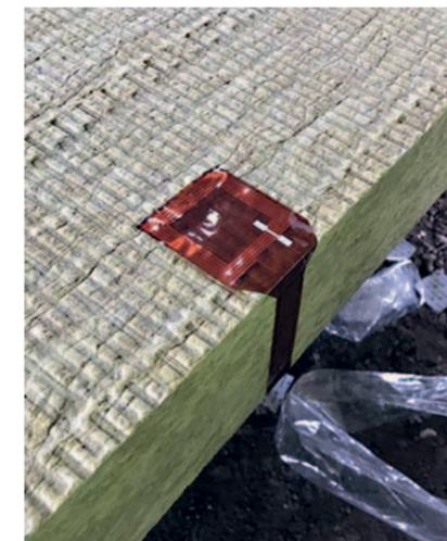
▲ Der Sensor wird in der Dämmschicht eingebaut und liegt auf der Dampfsperre
