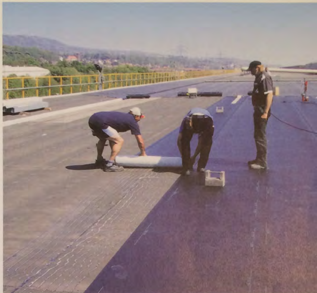
▲ Bei der teilflächigen Verlegung werden die Bahnen einfach in den Kleber eingerollt. Diese Ausführung kommt vor allem dort zum Einsatz, wo eine mechanische Befestigung nicht möglich ist
