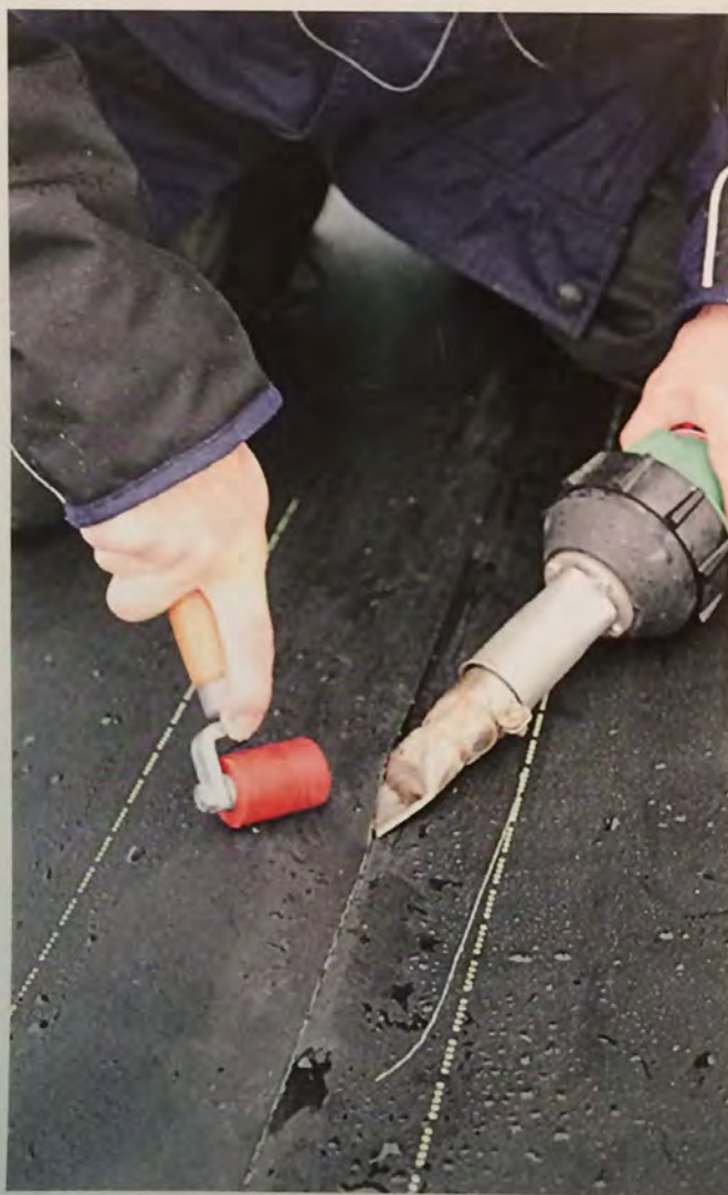
Anschlüsse und Durchdringungen dichteten die Dachdecker mit dem Handschweißautomaten und einer Andrückrolle an.
