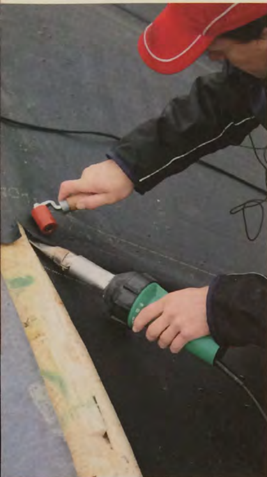
▲ Mit der Thermofast-Technik lassen sich sichere Nahtverbindungen herstellen
