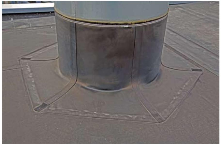
Am Beispiel eines großen Entlüftungsrohres zeigen sich die Vorteile einer werksseitig vorgefertigten Manschette.
