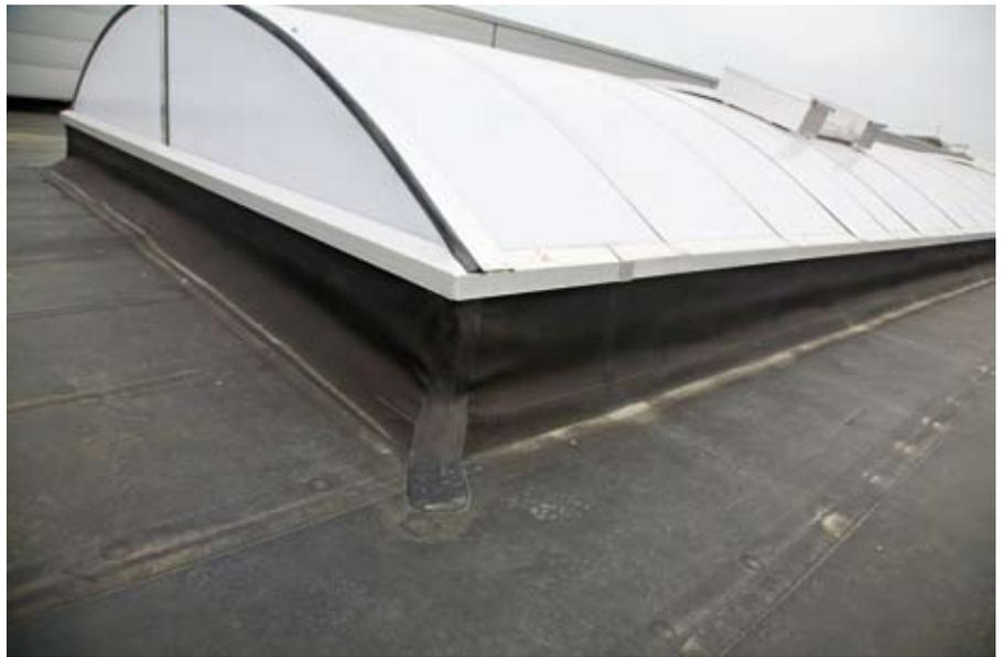
eckmanschette gezeigt. Mehr als 600 verschiedene Standardformteile und werkseitig nach Aufmaß konfektionierte Manschetten wurden so für die sichere Einbindung von Blitzableiter, Absturzsicherungselementen, Lichtkuppeln und diversen Rohrdurchführungen eingebaut.
