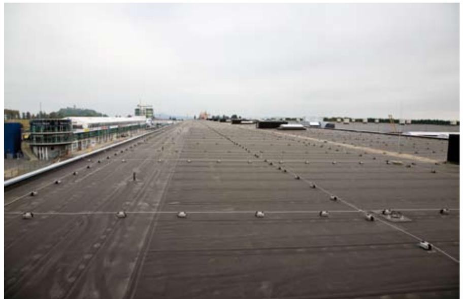
Die Lagesicherung der Dachbahn sowie des gesamten Schichtenpaketes erfolgte durch die mechanische Befestigung.
