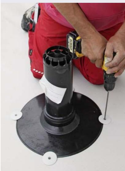
Jedes Lüfterelement wurde mechanisch fixiert.
