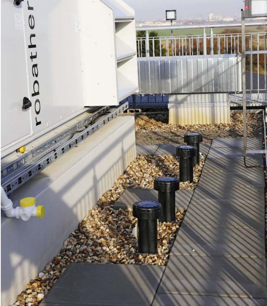
Jedes Zimmer des aufgesetzten Hotels wird mit einer eigenständigen Lüftungsanlage und dem Flachdach-Lüfter durch die Dachabdichtung entlüftet.
