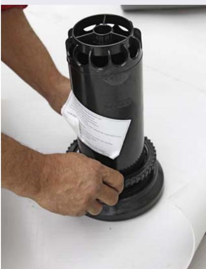
Mit einem Klemmflansch wird die homogene Dichtmanschette der Abdichtungsbahn sicher und wasserdicht fixiert und anschließend mit einem Heißluftschweißgerät sicher abgedichtet.
