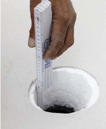
Die Dachbahn wurde an entsprechender Stelle geöffnet und ein passgenauer Ausschnitt für die Rohrdurchführung erzeugt.
