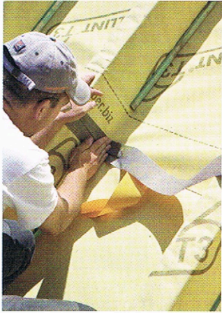
Die luftdichte Verlegung einer neuen Luftsperr Ebene erfordert mittlerweile eine hygrothermische Simulation
