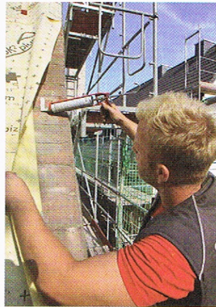
An allen Außenbauteilen wird die neue Dampfsperre luftdichtend angeschlossen
