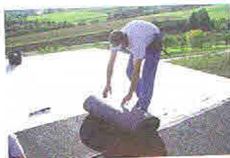
Strukturierte Trennlagen verbessern die Gleitfähigkeit der Schere, gleichen Unebenheiten in der Unterkonstruktion (Holzschüsselungen, hervorstehende Nägel) aus, und reduzieren Reibungsschäden.
